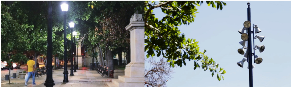
Figura 15: Ejemplos de mantención de la vegetación en el espacio público
